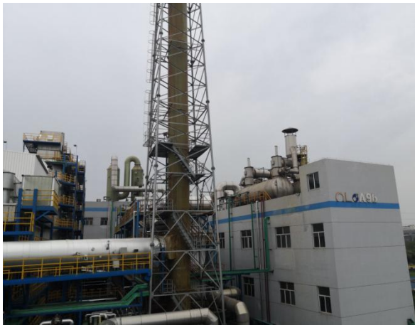
回转窑 50m 排气筒 (1#)
