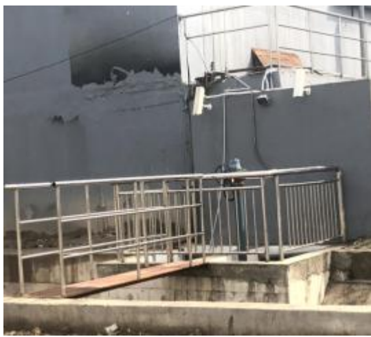
4.1-12 雨水排放口在线监控、可控阀门及标示牌
