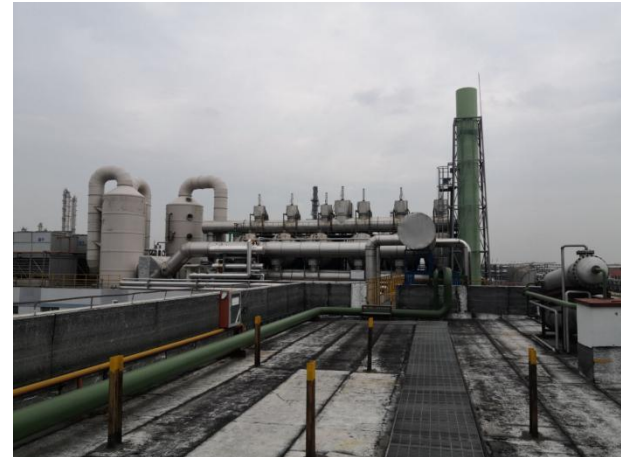
冷冻+稀酸吸收+碱吸收+除雾+两级活性炭吸附/脱附/ (6#) 排气筒
