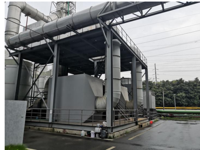
稀酸吸收+碱吸收+除雾+光氧离子催化氧化+活性炭吸附/ (14#) 排气筒
