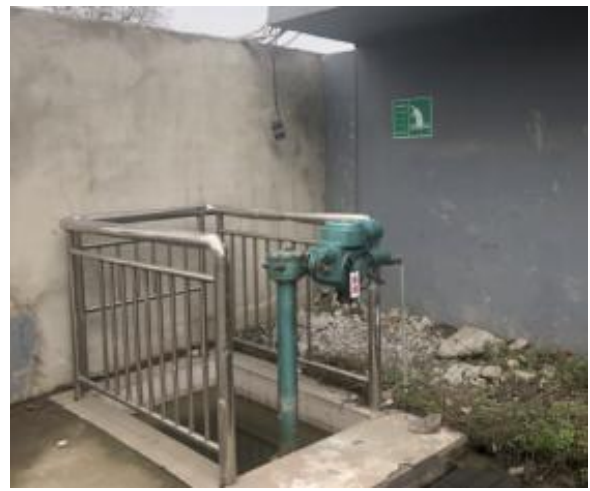
4.1-12 雨水排放口在线监控、可控阀门及标示牌
